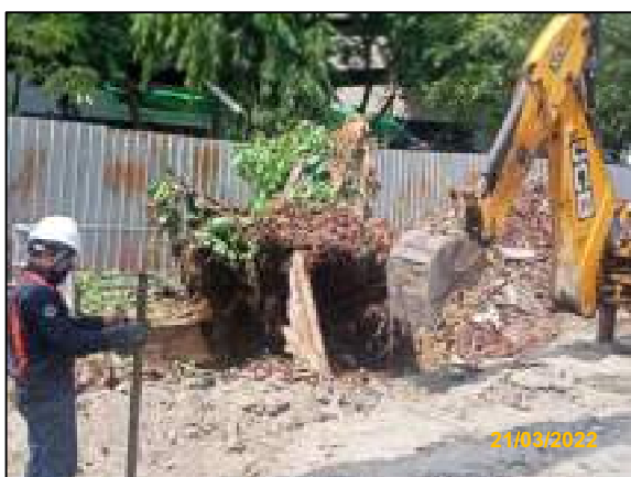
ง) การจัดเตรียมพื้นที่ก่อนเริ่มการก่อสร้าง (Clearing)
