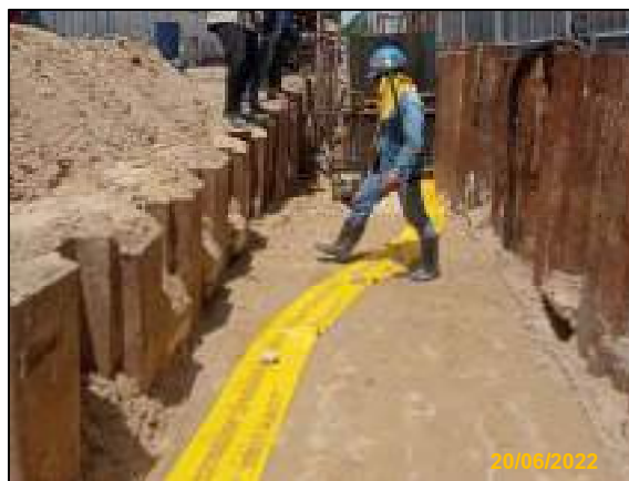
ข) การวางแผนคอนกรีตและวางเทพื้นป้องกันท่อขนส่งน้ำมัน
