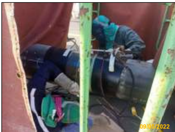
ข) การเชื่อมประกอบท่อ (Pipeline Welding)
