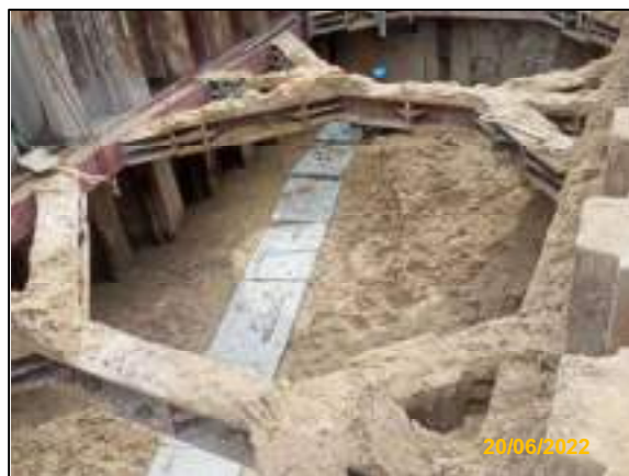
ข) การวางแผนคอนกรีตและวางเทพื้นป้องกันท่อขนส่งน้ำมัน
