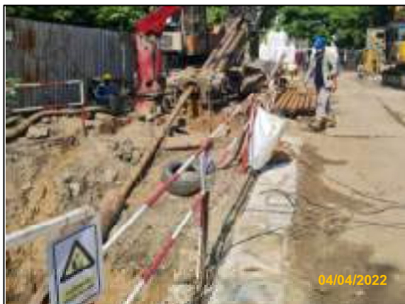
ก) การวางท่อขนส่งน้ำมันด้วยวิธีเจาะลอด (HDD)
