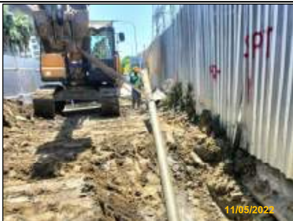
ก) การวางท่อด้วยวิธีเจาะลอด (HDD)
