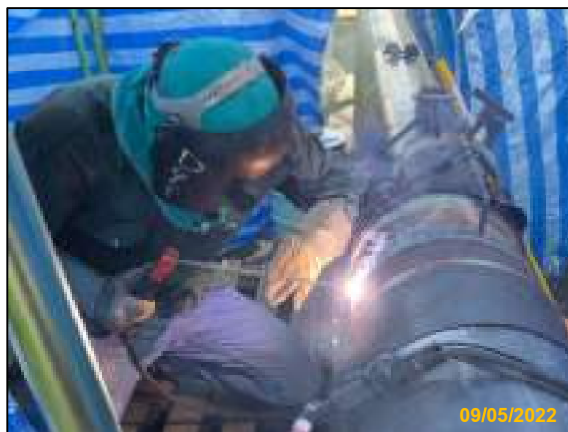
ข) การเชื่อมประกอบท่อ (Pipeline Welding)
