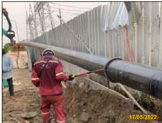
ค) การทดสอบหารอยรั่วในวัสดุเคลือบผิว Holiday Test
